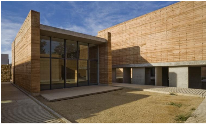
Escuela de artes visuales de Oaxaca, Mauricio Rocha, Taller de arquitectura. nótese el uso de colados de adobe para la contextualización del objeto arquitectónico en su localidad.
