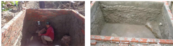
Figura 6. Construcción de la cámara - paredes (izquierda) y colocación de ladrillos (derecha) aplicación de ferrocemento [7]
