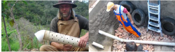
Figura 7. La construcción de la cámara - la instalación de tuberías [7]
