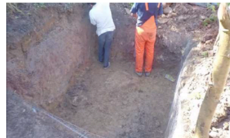
NEC32 a 5. Construcción de la cámara - excavación de la cámara [7]
