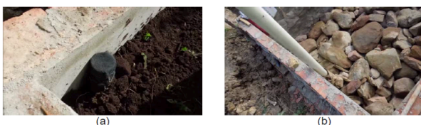
Figura 10. Construcción de la cámara: a) tubería usando un filtro y b) instalación de una tubería [7]
