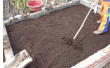
Figura 11. Construcción de la cámara – Establecimiento de suelo fértil. [7]
