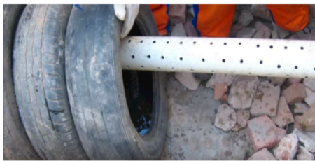
Figura 8. Construcción de la cámara - neumáticos para protección [7]
